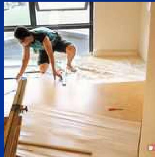
不須拆除舊地面，鋪上防水和隔音墊後，就能拼組軟木地板，將來搬家也能拆下再利用。施工工資，每坪900元。
